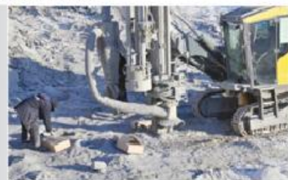
Монтаж взрывной сети
