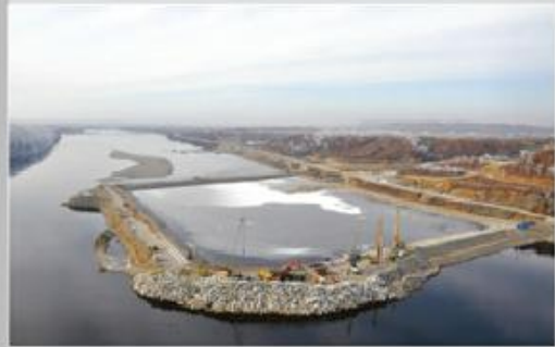
Перемычки котлована основных бетонных сооружений. Вид с водоема быфа
