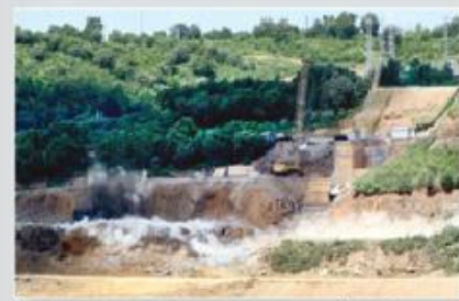
Разрывание скальных грунтов скважинными зарядами вблизи бетонированных секций правобережной бетонной плотины
