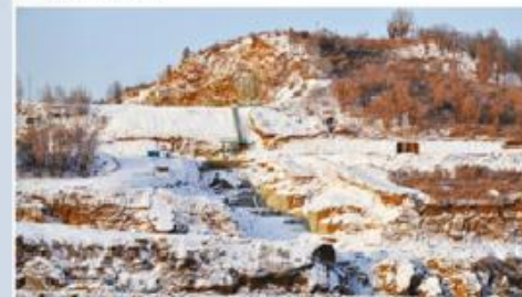
Котлован правобережной бетонной плотины. Общий вид
