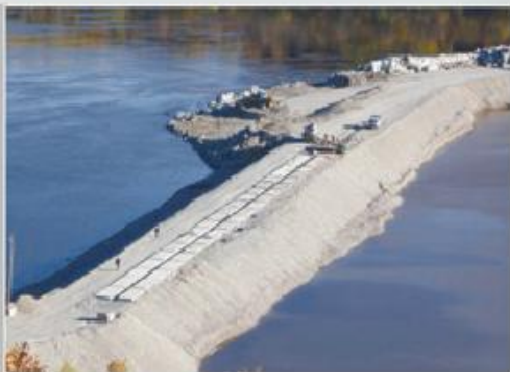
Бетонирование монолитной железобетонной фермы
