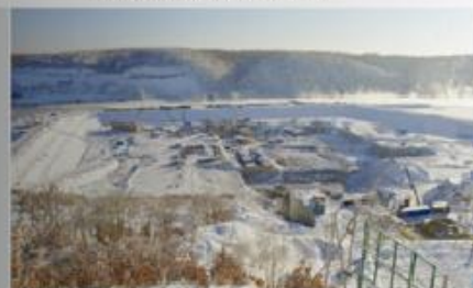
Котлован основных бетонных сооружений
