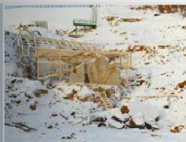
Возведение утепленного пола на участке пилежит
