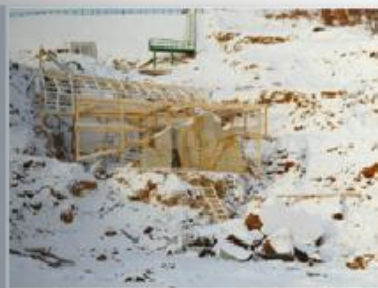
Возведение утепленного пола на участке пилежик
