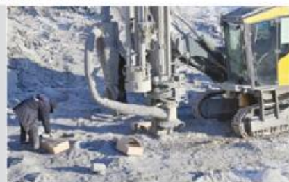
Монтаж взрывной сети
