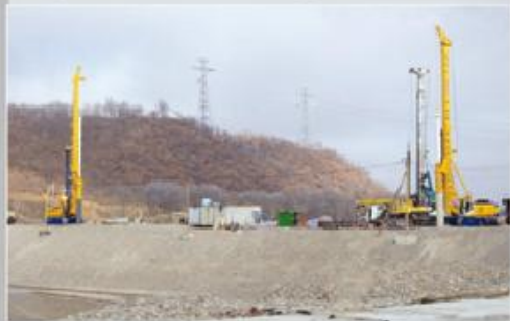
Бурение скважин буровыми станками Wagner BG 42 и Wagner BG 26
