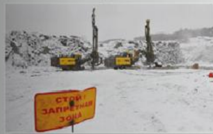
Бурение скважин под установку штурвальных зарядов станками Atlas Copco
