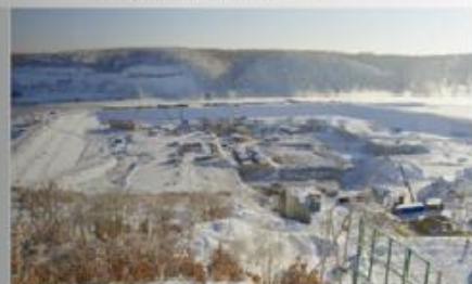
Котлован основных бетонных сооружений
